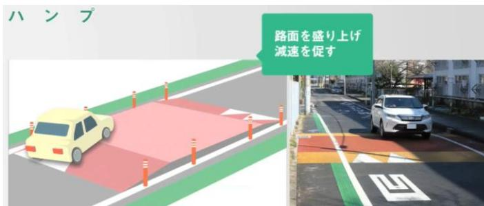
※3 「歩車共存構造」…道路の拡幅が困難な路線において、車道と歩道の幅員の再配分や路面の視覚的な効果により、車両の通行速度の抑制を図るものです。
